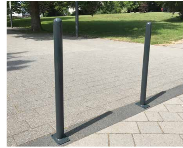
Absperr-Stilpfosten aus Stahlrohr, Ø 60 mm, ca. 950 mm Überflur, feuerverzinkt und beschichtet
