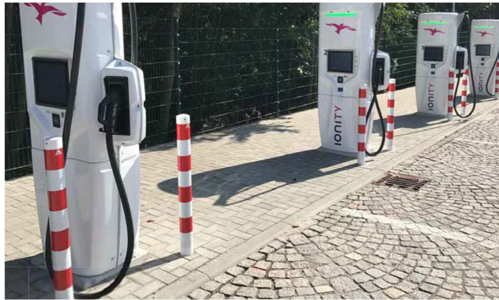
Absperrpfosten als E-Ladesäulenschutz mit aufgeschweißter Stahlkappe, 900 mm Überflur
