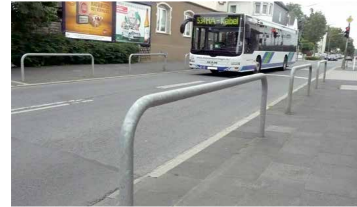
Abweisebügel Stahlrohr Ø 76 x 2,6 mm ohne Querholm
