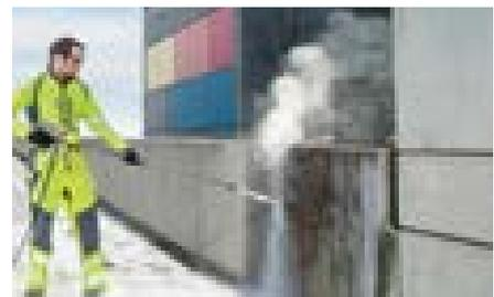
Hochdruckreinigung mit bis zu 200 bar
