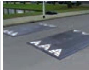
Zur Geschwindigkeitsdämpfung innerhalb von Tempo-10- und Tempo-30-Zonen. Sowohl für Knotenpunkte als auch auf Strecken (Straßenzüge) einsetzbar.
