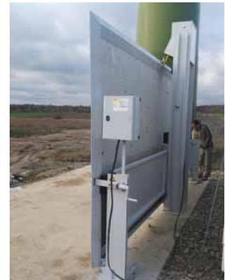
Schutzkasten für Steuerbirne bei der Ausführung mit Elektrokettenzug
