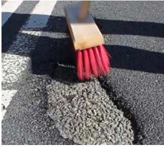
Reinigen Sie den zu reparierenden Bereich.
