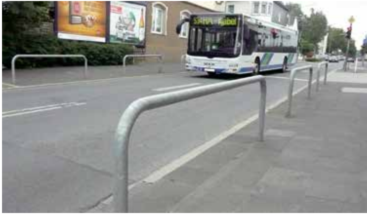
Abweisebügel, Stahlrohr Ø 76 x 2,6 mm ohne Querholm
