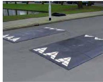
Kissens quer zur Fahrbahn erreicht. Hier sorgt die steilere Anrampung und der kurze Überfahrtsweg für eine deutlich unangenehmere, fahrdynamische Wirkung.
